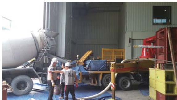
4. 거푸집설치 및 콘크리트 타설2
