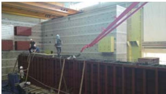
3. 거푸집설치 및 콘크리트 타설1
